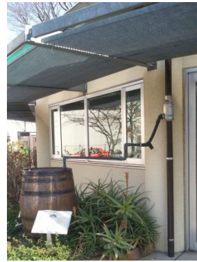
中目黒の雨水タンク 新津撮影
