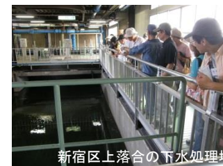
新宿区上落合の下水処理場
